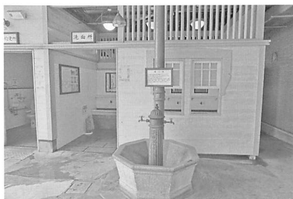
写真14 往時のまま残る門司港駅の洗面所
