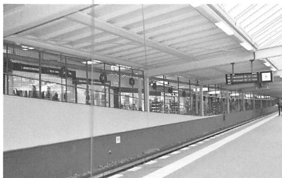
写真2 地下鉄オンケルトムズヒュッテ駅のホーム
