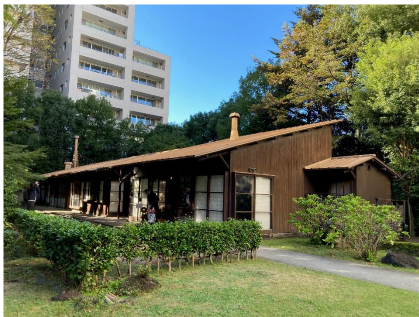
写真-6 旧井上房一郎邸 南東外観
