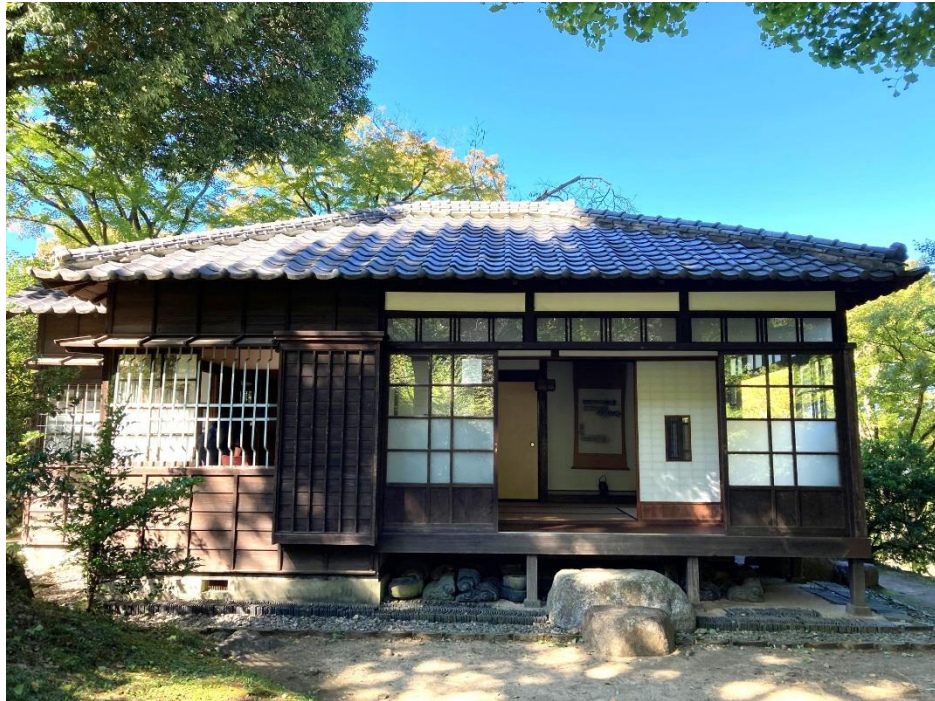
写真-2 洗心亭_東側外観
