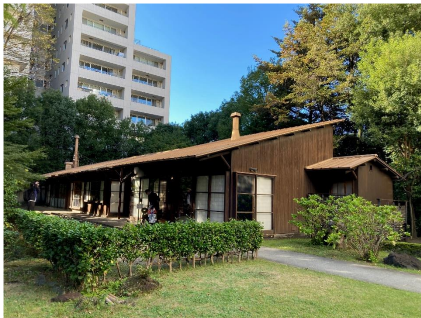
写真-6 旧井上房一郎邸 南東外観
