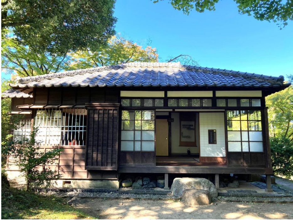
写真-2 洗心亭_東側外観
