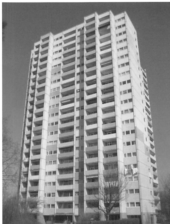
図5 Stuttgartで省エネルギー改修が行われた高層集合住宅
