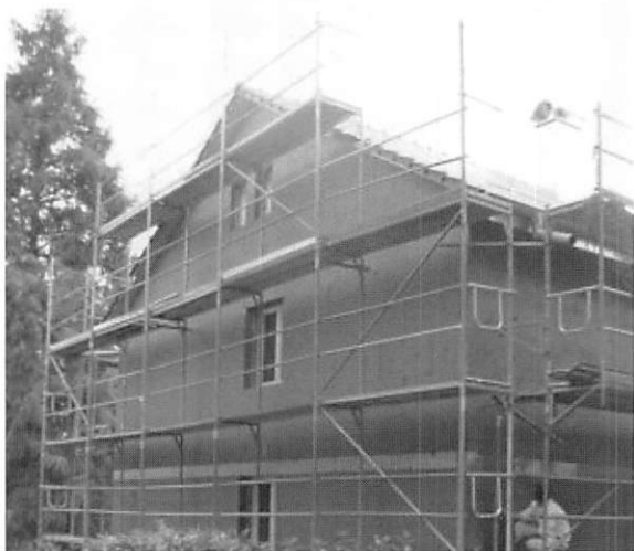
図6 既存住宅の省エネルギー改修（窓の交換と湿式外断熱工法）
