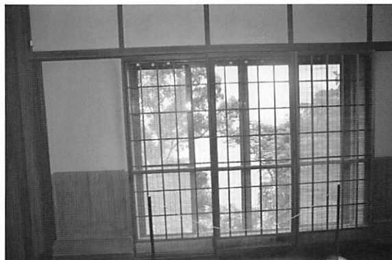
写真10 相模湾の面する開口部に設けられた葦障子
