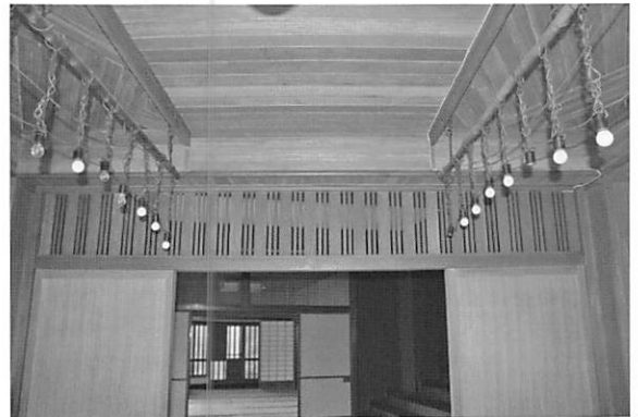
写真8 桐の板を小さな幅で張った天井
