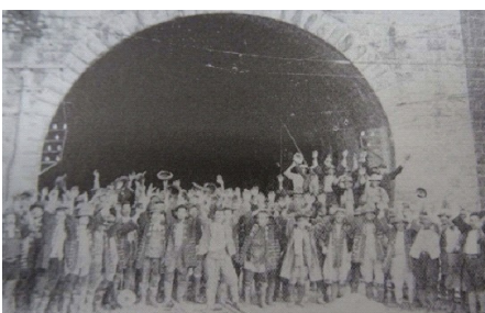
◎丹那トン熱開通（昭和9年）
