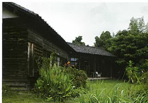
↓東側の階段を降りていくと、青々とした木々の中に建物が見える。 ↑南側より見る。平面はくの字形に折れ曲がっている。
