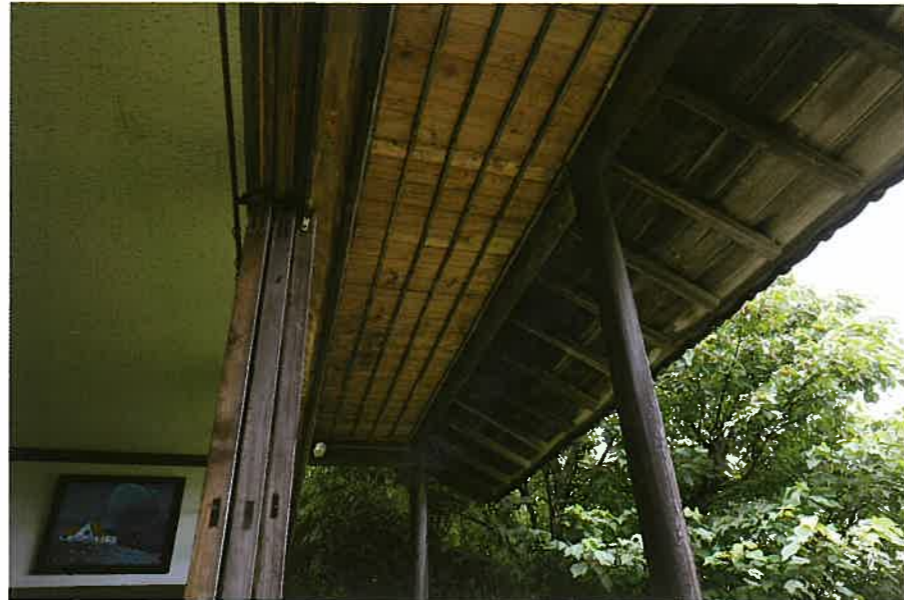
テラス上部。2本の円柱が軒を支える。
