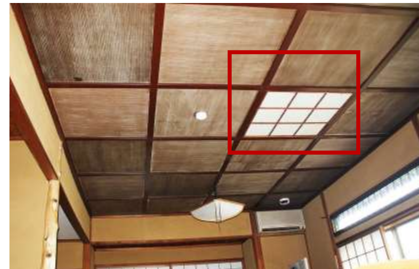
天井 地下室へ影響
