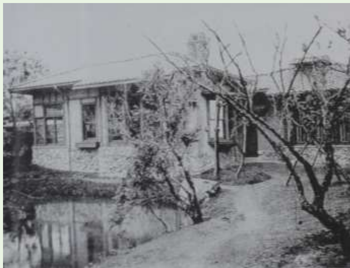
洋館1 (客室・金剛+ローマ風浴室)
